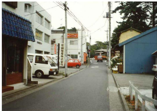
整備前の状況写真
