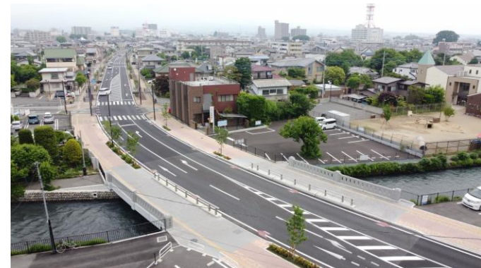
整備後の状況写真
