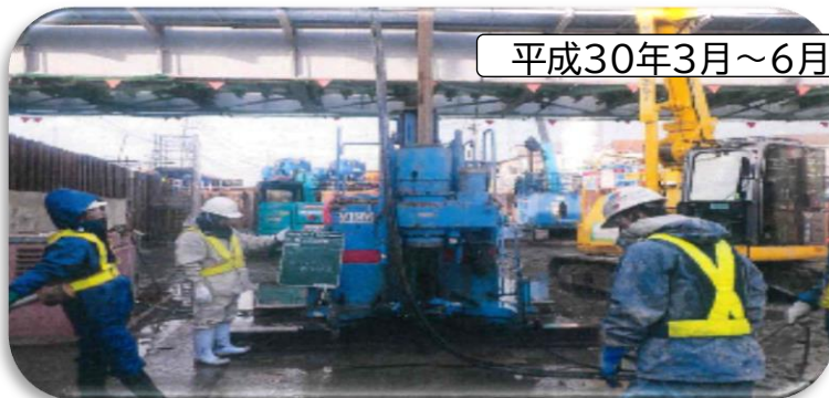
地盤にセメントを注入する作業
