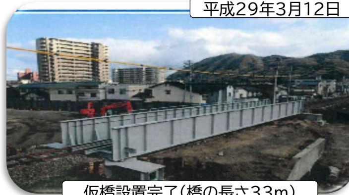
仮橋設置完了(橋の長さ33m)
