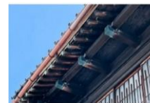
セカイ(配飾) 深い軒先を確保し、風雨や日差しから建物を守るため、柱から腕木がせり出し、懸状の小天井をもつ構造
