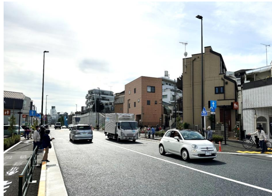
無電柱化により電柱倒壊による道路閉塞を防止
