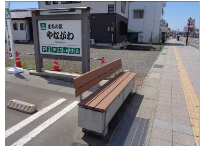
防災ベンチの設置状況
