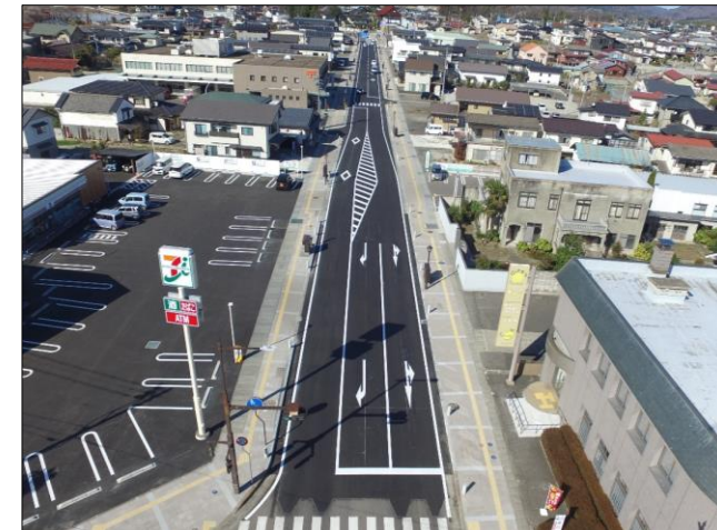
整備後(起点より)
