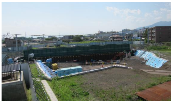
工事桁下の掘削
