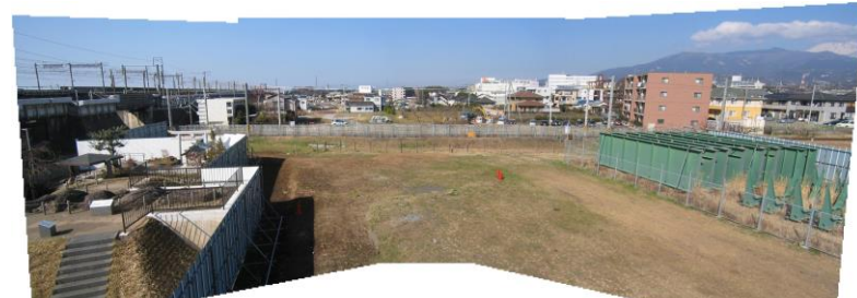
古墳移設後と工事着手前の全景
