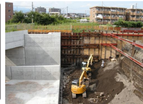
施工状況 平成29年5月撮影
