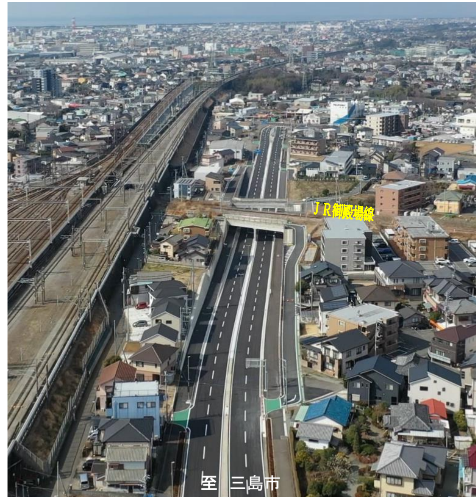
鉄道との立体交差部
