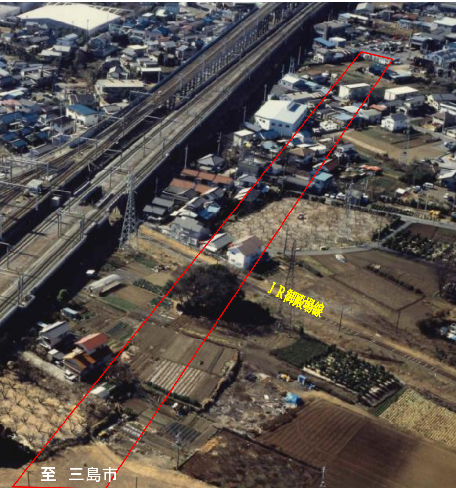
鉄道との立体交差部
