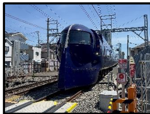
高石接続部仮上り線
