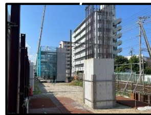
高架構造物の柱建造
