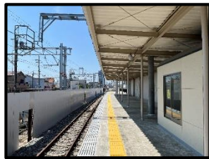
浜寺公園駅仮下りホーム
