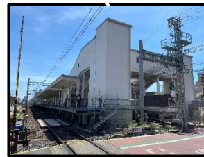
諏訪ノ森駅仮下りホーム
