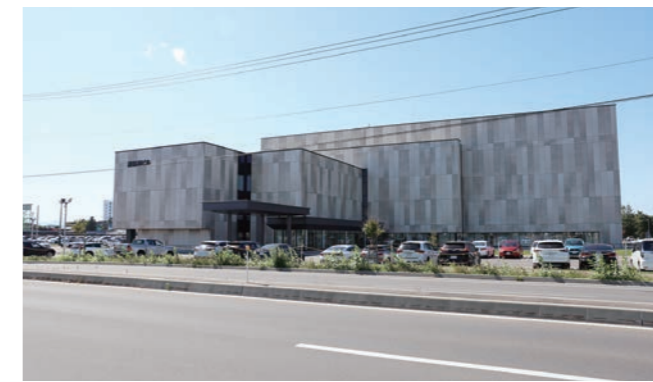
道路整備を契機に農協連ビルが新たに立地
