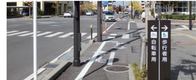
交通規制看板のほか歩車分離標識を設置
