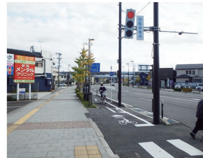
自転車道は対面通行のため自転車用信号機を設置
