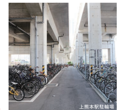
上熊本駅駐輪場
